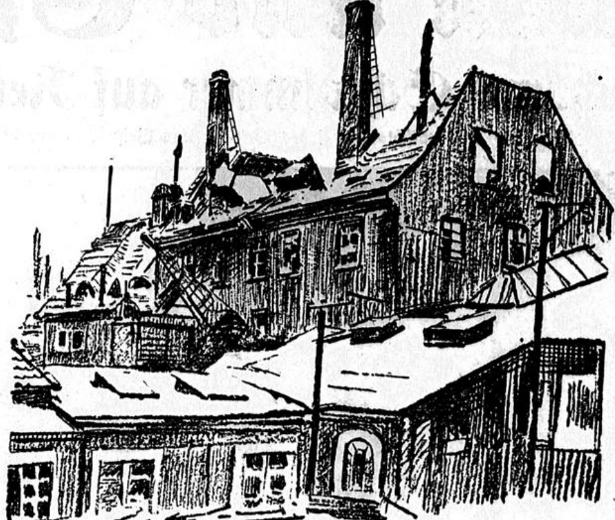
Das althistorische ehemalige Kanonenbrennwerk in Dresden - Löbtau, das seit über 100 Jahren stillgelegt war, wurde kürzlich durch Feuer fast vollständig zerstört.
