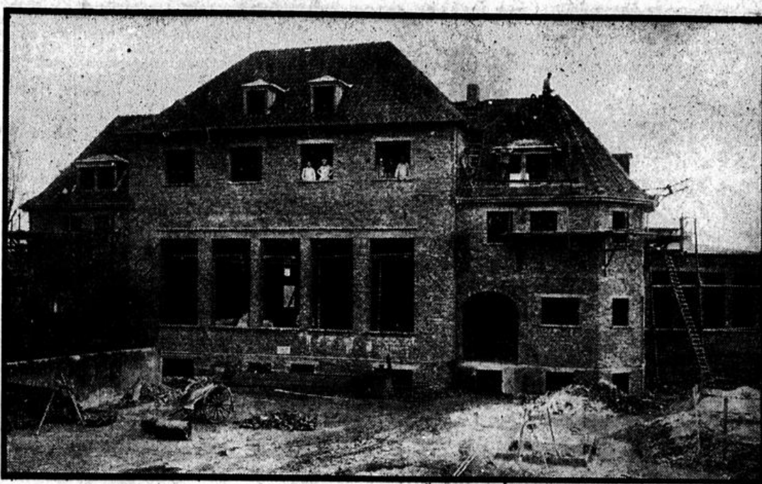
An der Amtsstraße in Hamme errichtet die evangelische Gemeinde Hamme ein Gemeindehaus, das den verschiedenen Zweigen des kirchlichen Gemeindelebens
