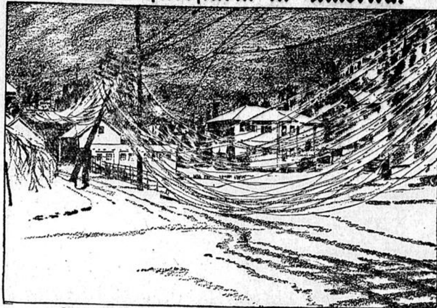
Durch Schneestürme zerstörte Telegraphenleitungen in den nördlichen Vereinigten Staaten.
