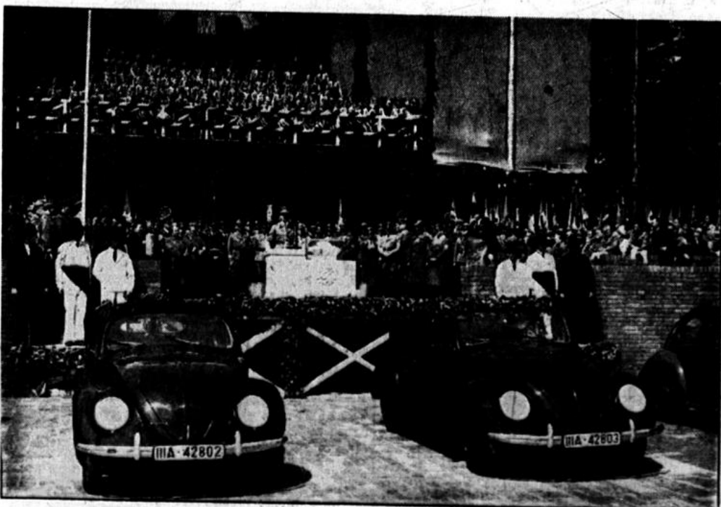
In einem festlichen Akt legte der Führer am Himmelfahrtstage vor 70 000 Volksgenossen aus allen Teilen des Reiches auf dem Werkplatz bei Fallersleben den Grundstein zum größten Kraftwagenwerk der Erde, dem Volkswagen-Werk. — Der Führer spricht anlässlich der Grundsteinlegung zu den Volksgenossen. Vor dem Podium zwei der Wagen, die nach Fertigstellung des Werkes hier an Ort und Stelle hergestellte Aufnahme Weltbild.
