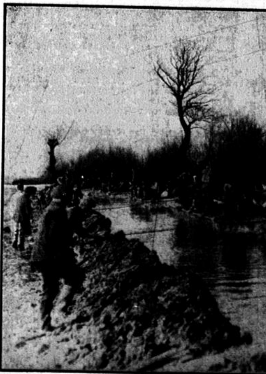
Deichbruch-Katastrophe in England. Tausende von Männern kämpfen vier Tage und vier Nächte gegen das Hochwasser im englischen Fenland. Trotz des höchsten Einsatzes konnten die Deichmannschaften nicht verhindern, daß die Gewalt des Wassers den Ousestamm brach und erneut weite Landstriche unter Wasser setzte. In großen Lastkähnen wurde Material für den Deichbau herangeschafft. (Scherl)
