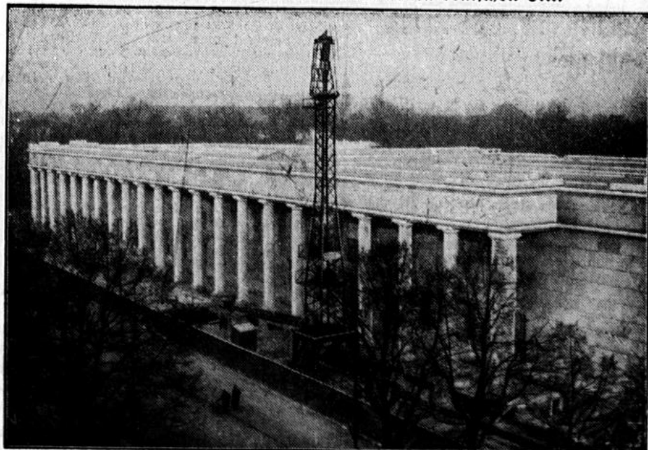
Das herrliche Haus der deutschen Kunst, das in der Prinzregentenstraße in München gebaut wurde, ist jetzt von den Baugewerken befreit worden. Die 175 m lange Säulenhalle bietet nun dem Besucher ein Bild von großer architektonischer Schönheit dar, ein Beispiel des neuen deutschen Stils. (Scherl-M)
