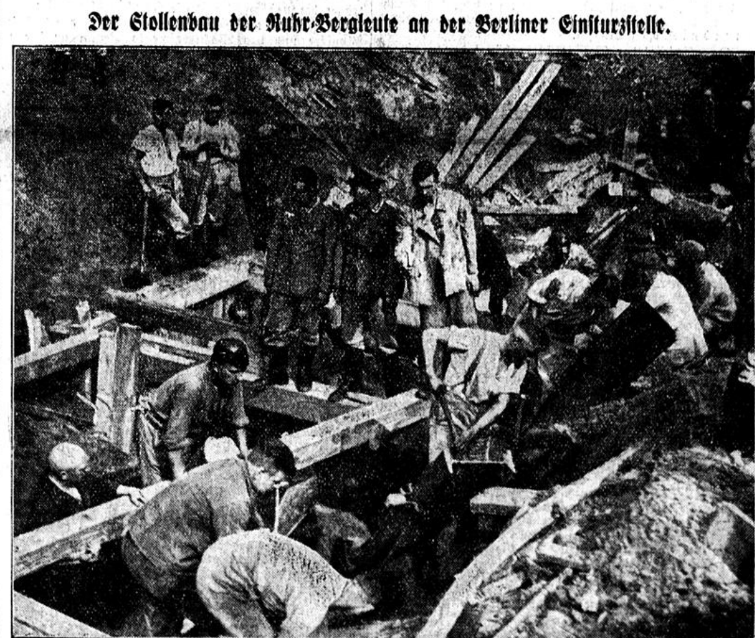
Die Aufnahme zeigt die Arbeit der Bergleute im Verein mit den übrigen Hilfsmannschaften beim Einbau des Stollens in den Tunnel. (Scherl-Bilderdienst-M.)
