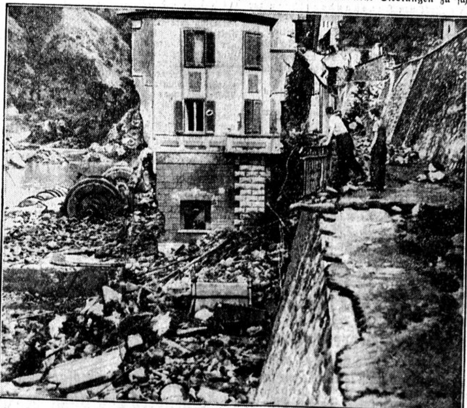
Dieses Bild gibt einen Eindruck von der gewaltigen Zerstörung, die das entseelte Element anrichtete. Man sieht ein zerstörtes Kraftwerk in der Nähe von Ovada. Die Turbinen sind durch die Gewalt des Wassers völlig freigelegt worden. (Wise World-M.)
