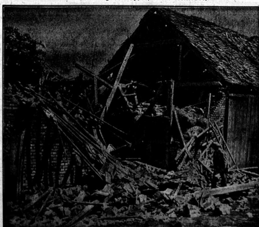
Das Explosionsunglück in den Reinsdorfer Sprengstoffwerken hat auch in der näheren Umgebung Verwüstungen verursacht. Unser Bild zeigt ein schwer betroffenes Bauerngehöft in Braunsdorf. (Scherl-M.)
