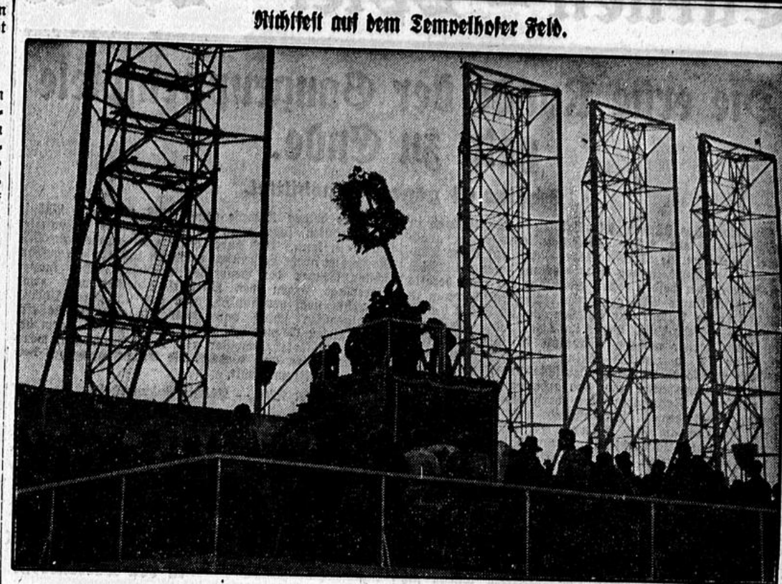
Die Tribünenbauten für die diesjährige Feier am „Nationalen Feiertag des deutschen Volkes“ sind soweit gediehen, daß nach altem Brauch das Reichsfest gefeiert werden konnte. Unser Bild zeigt das Aufrichten der Richtkrone in Gegenwart aller an den Arbeiten beteiligten Arbeitskameraden.
