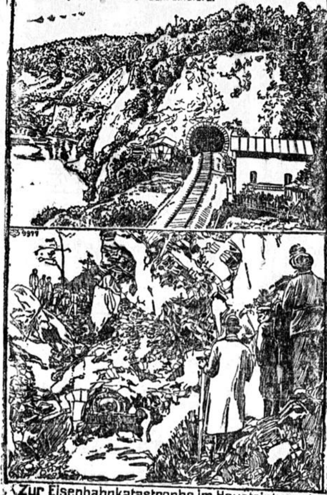
Zur Eisenbahnkatastrophe im Hauselintunnel bei Chemnitz.
