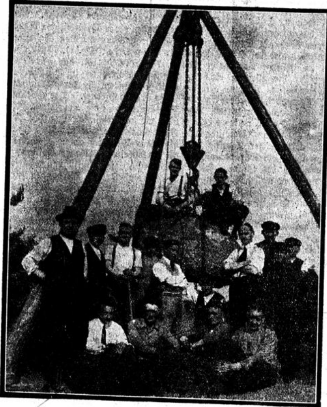
Wie der Denkmalstein gehoben wurde.
