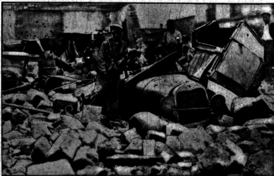
Automobile, die von den Trümmermassen fast vollständig verschüttet wurden.
