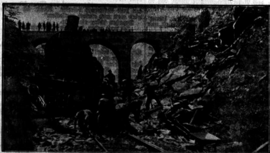
Ein plötzliches Erdbeben, das sich in einer Schlucht vor dem Bahnhof Lingenberg im Hunsrück ereignete, verursachte die Entgleisung eines Zuges. — Sechs Passagiere wurden verletzt.
