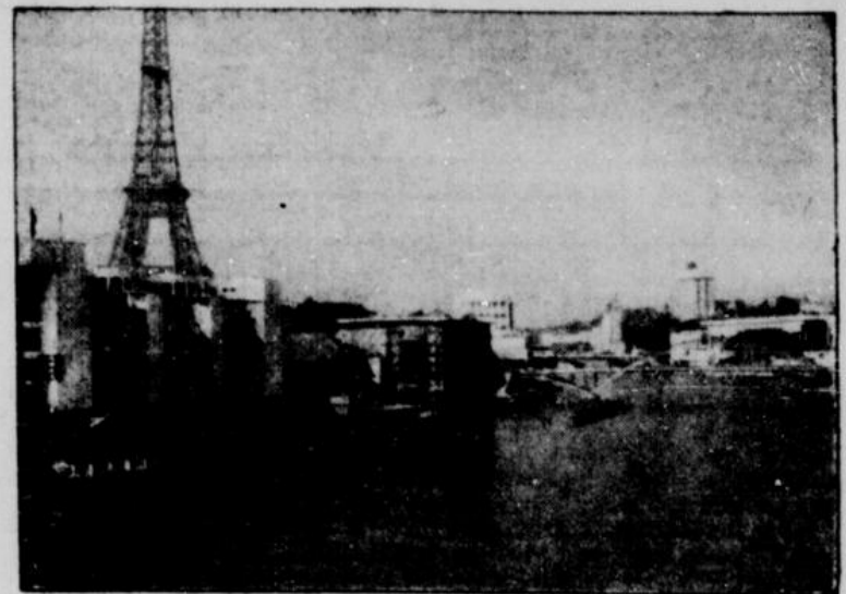
Ein Blick vom Pont de l'Alma auf die Ausstellung. Im Vordergrund einige noch unfertige französische Bauten: Touristik, Haus der Thermalbäder, Ausstellung des Landwirtschaftsministeriums. Die Brücke über die Seine im Vordergrund ist eigens für die Ausstellung geschaffen. Im Hintergrund der Pont d'Jena und die Pavillons der ausländischen Staaten. Rechts: das Deutsche Haus.
