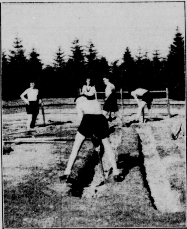
Die ersten Gräben werden für den Thingplatz gezogen.
