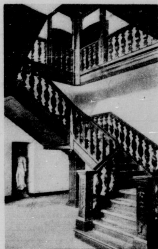
Das prachtvolle Treppenhaus
