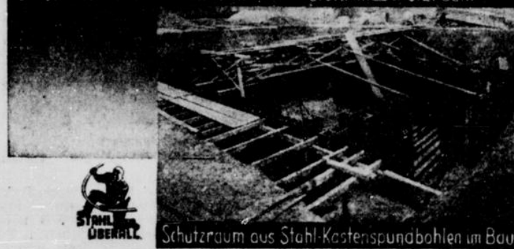
Schutzraum aus Stahl-Kastenspunaböhlen im Bau
