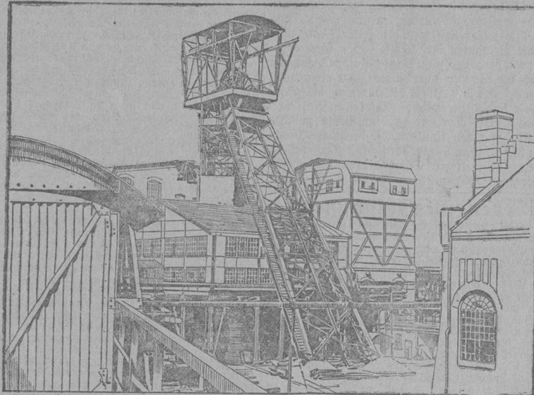
Die Förderanlage der Zeche „Hannibal I“ bei Bochum.
