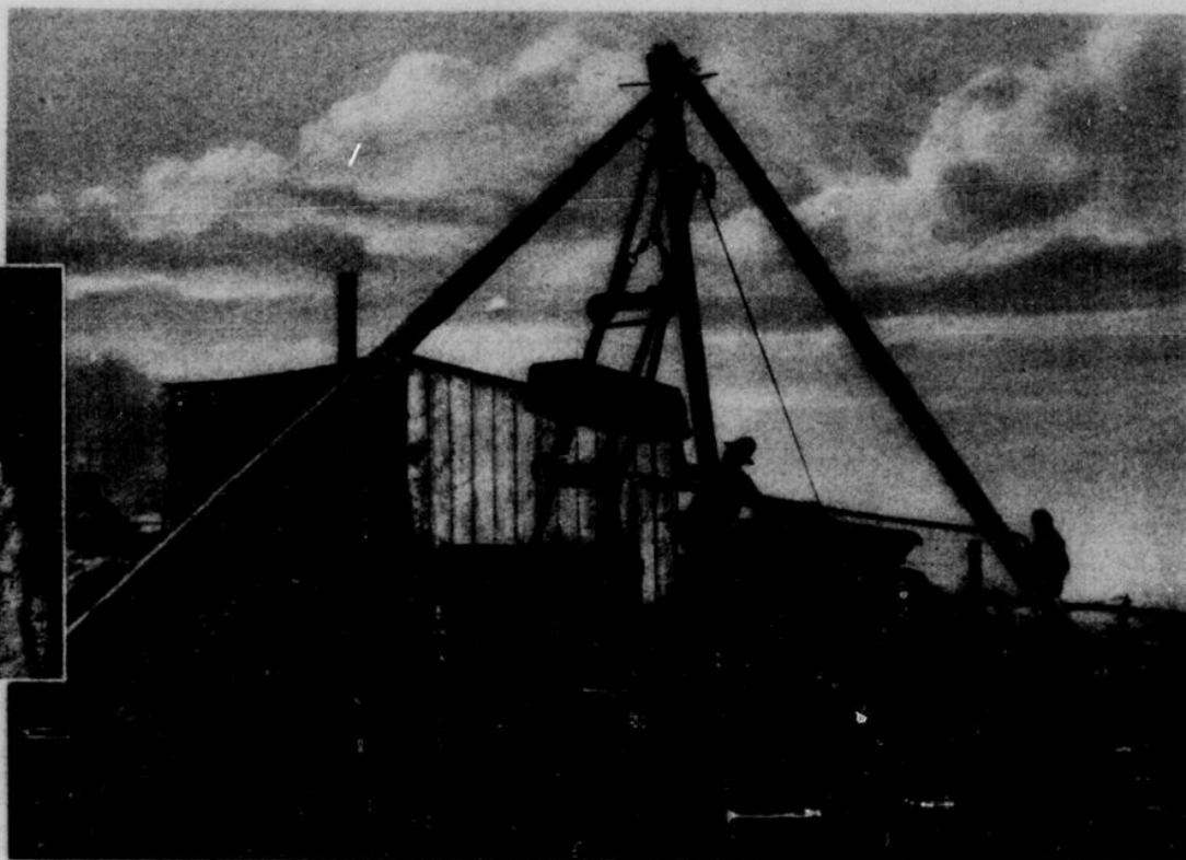
Der Förderturm besteht aus einem Dreibein mit Haspel
