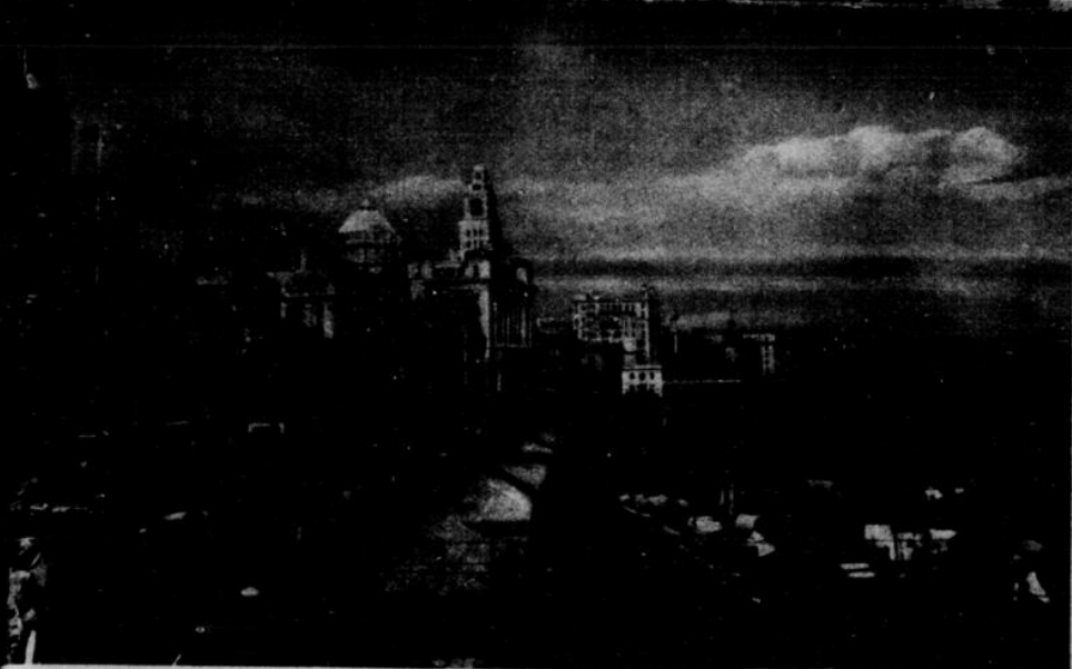
Der „Bund“ in Shanghai, die große repräsentative Straße der Banken und Verwaltungsgedäude der europäischen, amerikanischen und japanischen Firmen. Dies ist das Handelszentrum, das Ein- und Ausfuhrort dieses riesigen Reiches.
