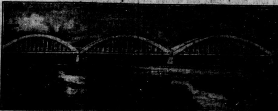
Die erste Eisenbrücke in Europa, die ohne Verwendung von Niete lediglich im Schweißverfahren hergestellt wurde, ist heute über den Brura-Fluß in Polen vollendet worden.
