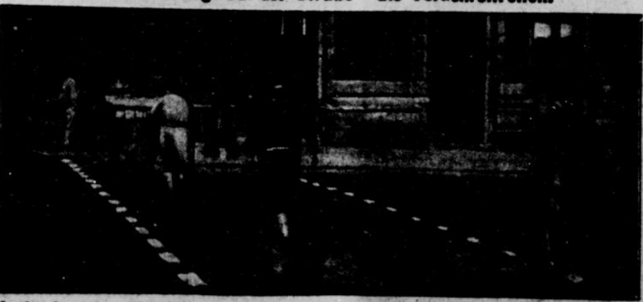
In den Straßen Wiens hat man die bisherigen, vom Gehsteig über die Fahrbahn führenden weißen Farbstreifen, die sich als wenig dauerhaft erwiesen haben, durch Gummistreifen mit weißer Oberfläche ersetzt, die zwischen Granitwürfeln eingebaut werden.
