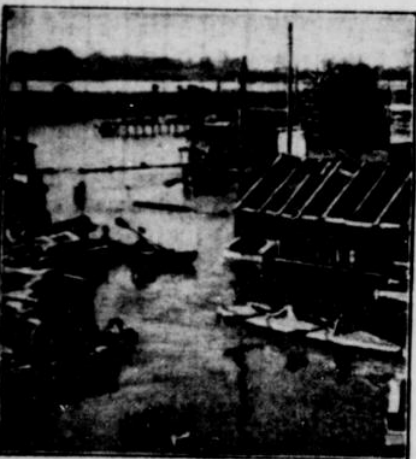
Vom Hochwasser überschwemmte Bauschuppen am Oderdamm bei Neusalz.
