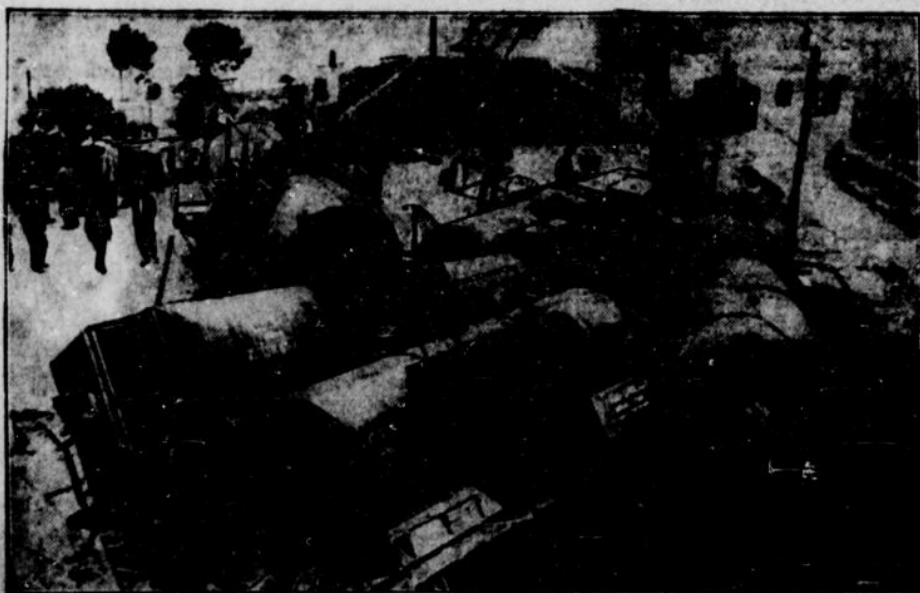
Die entgleisten Petroleum-Waggons.
