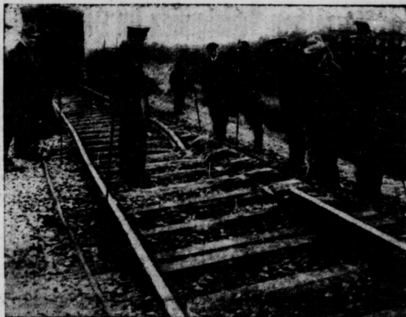
Polizei- und Eisenbahnbeamte bei der Untersuchung des gesprengten Gleiskörpers.
