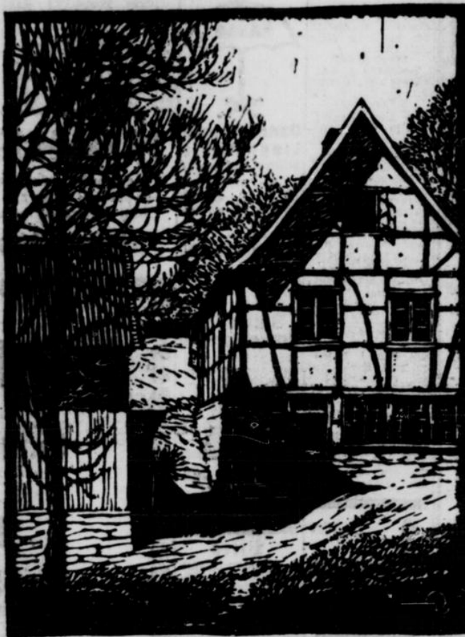
Ein altbergisches Haus in Breitenbruch
