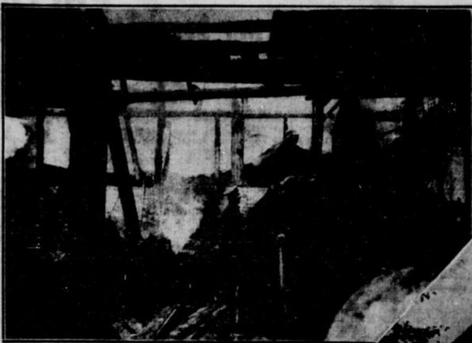
An der Brandstätte in der Varresbed.
