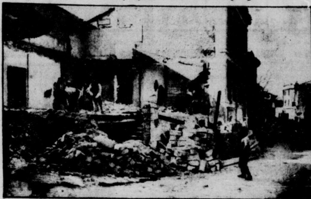
Unter Aufsicht amerikanischer Archäologen und Ingenieure begannen in Athen die umfangreichen Abbrucharbeiten, durch die der alte Marktplatz, die Agora, freigelegt werden soll. Unser Bild zeigt den Abbruch des ersten Hauses; alle auf dem Bilde sichtbaren Gebäude sollen der Spitzhacke zum Opfer fallen.
