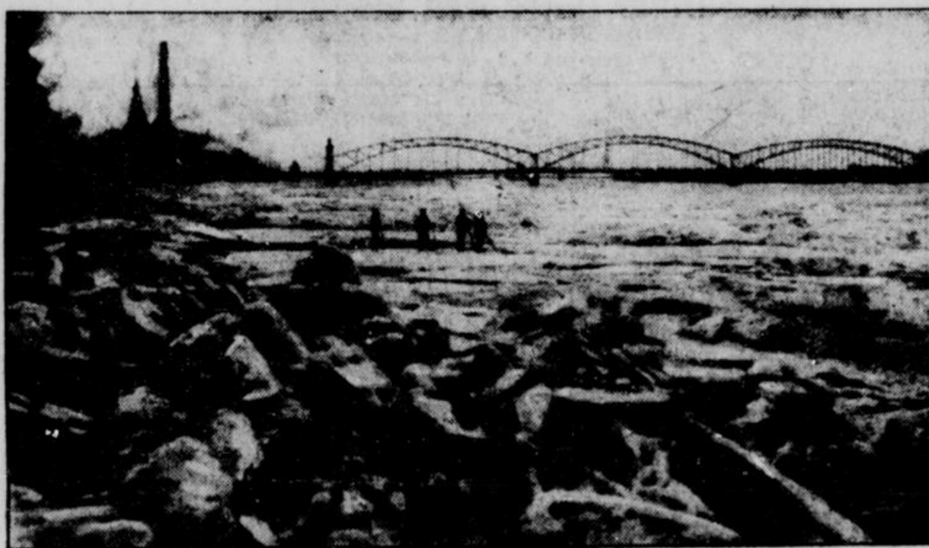
Im Hintergrunde die Luisenbrücke.
