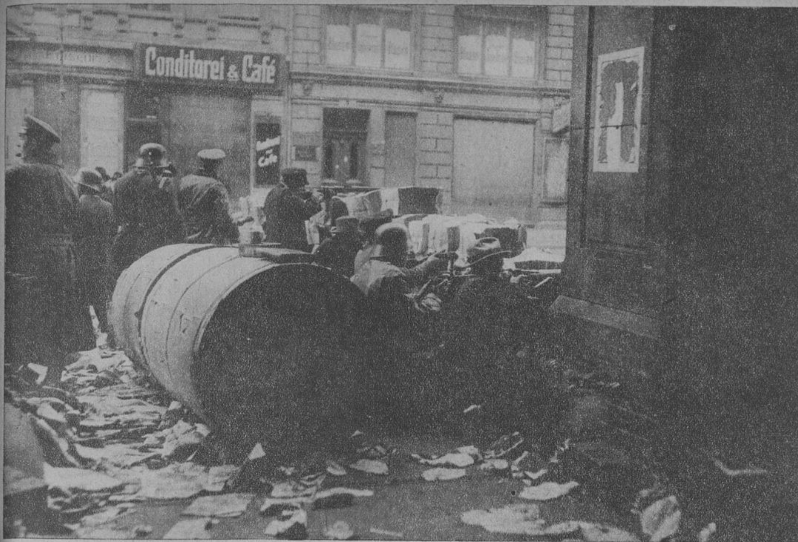
Maschinengewehrstellung der Spartakisten vor dem Verlagshaus Rudolf Mosse.
