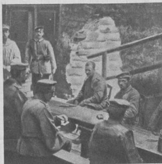
Phot. Stein Wohnung einer Feldküche im Keller eines zerstörten Hauses. Das Granatloch dient als Eingang
