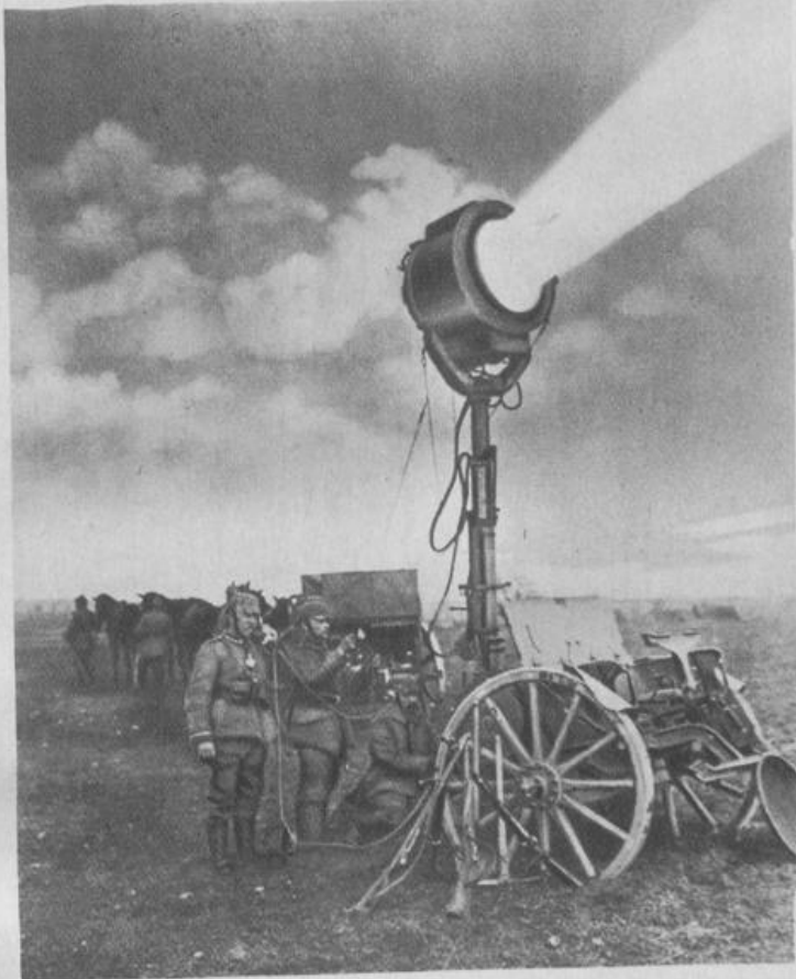
Die Rolle des Scheinwerfers im Kriege. Phot. Orohs Der Scheinwerfer in voller Tätigkeit. Links der Beobachtungsständer, daneben der Telegraphständer, der den feindlichen Züger der nächsten Artilleriestellung ankündigt
