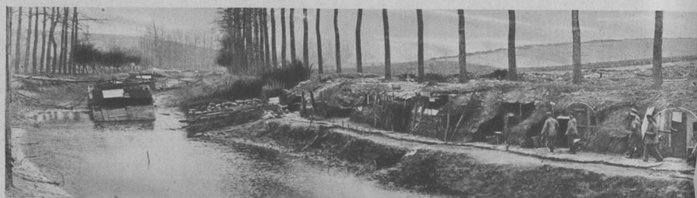
Deutsche Unterstände am Kanal zwischen Dife und Wisne
