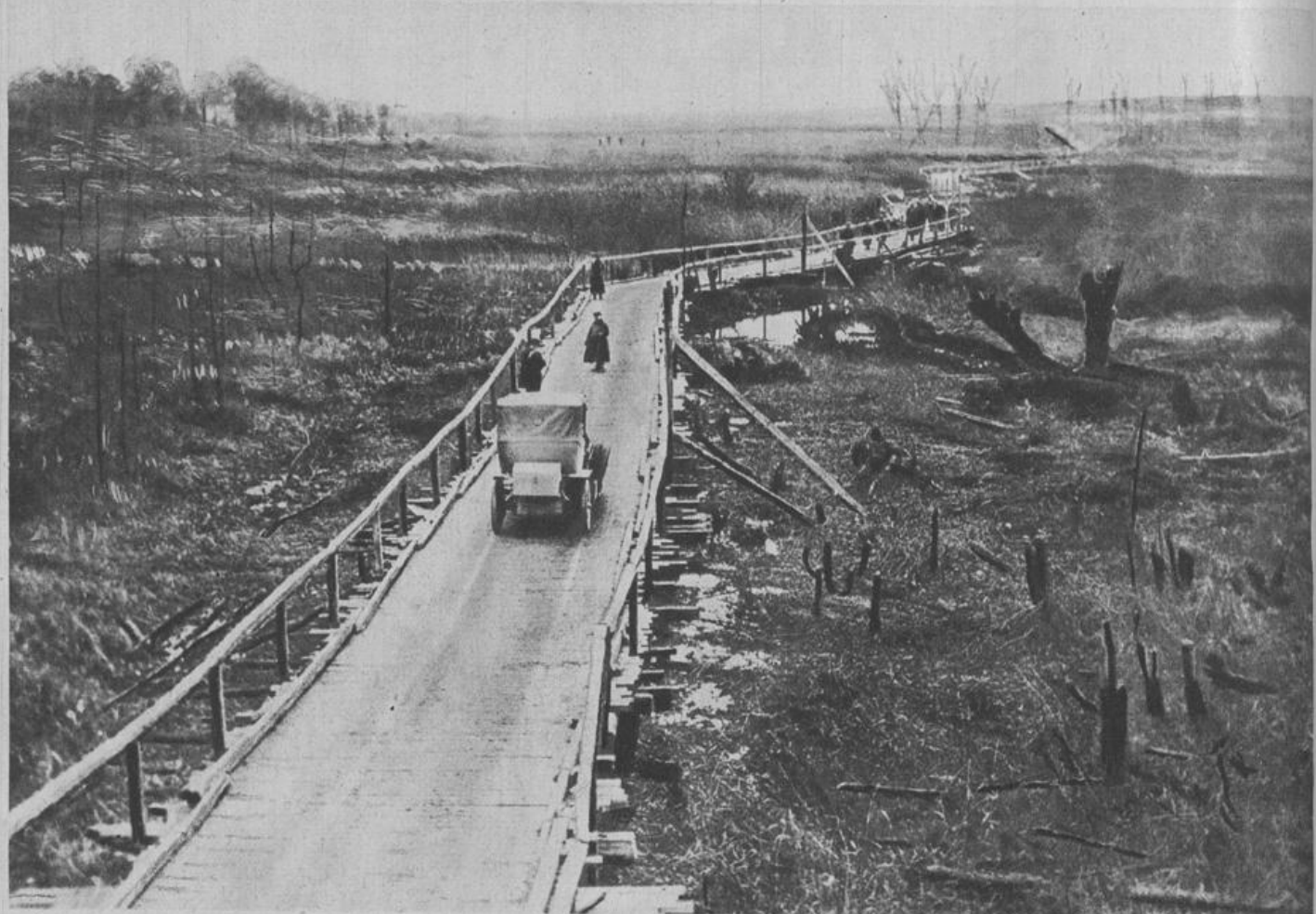
Aus Flandern: Im Ueberschwemmungsgebiet der Yser stellten deutsche Pioniere eine sich über das ganze Gelände erstreckende, binnen fünf Tagen passierbare Brücke her Phot. Grohs
