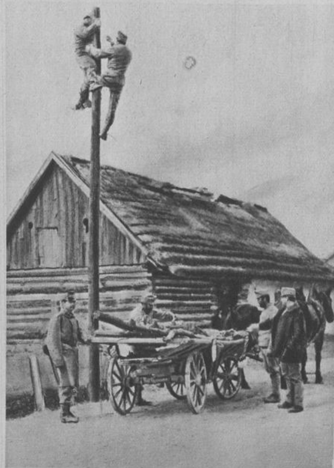
Wiederherstellung einer zerstörten Telegraphenleitung Kilophot G.m.b.H. durch die Oesterreicher an der Straße nach Neu-Sandec
