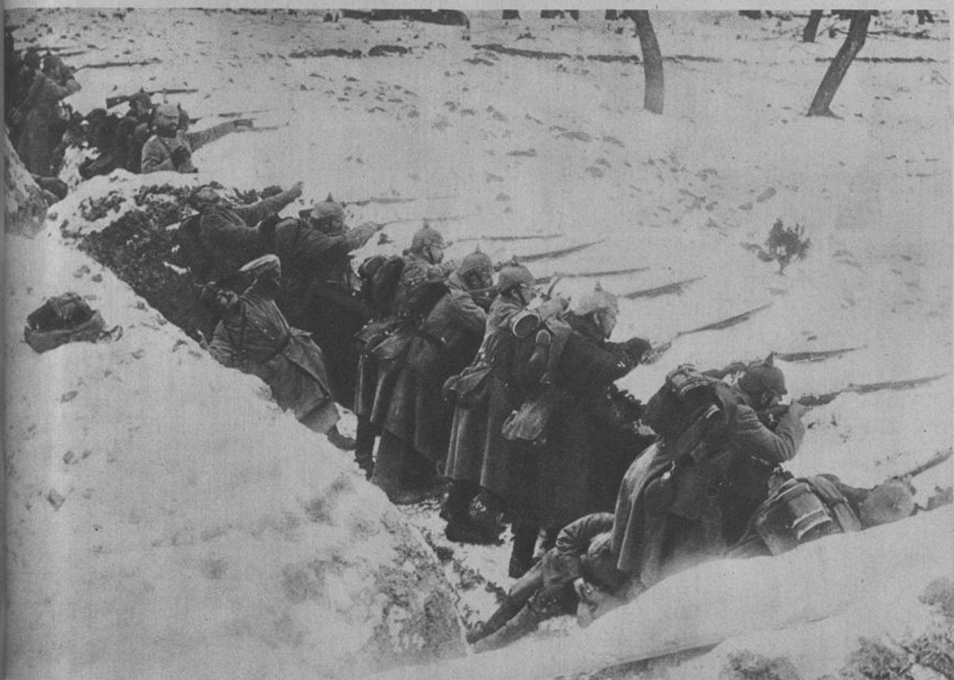
Im Schützengraben bei Darlehmen während eines schweren Gefechtes
