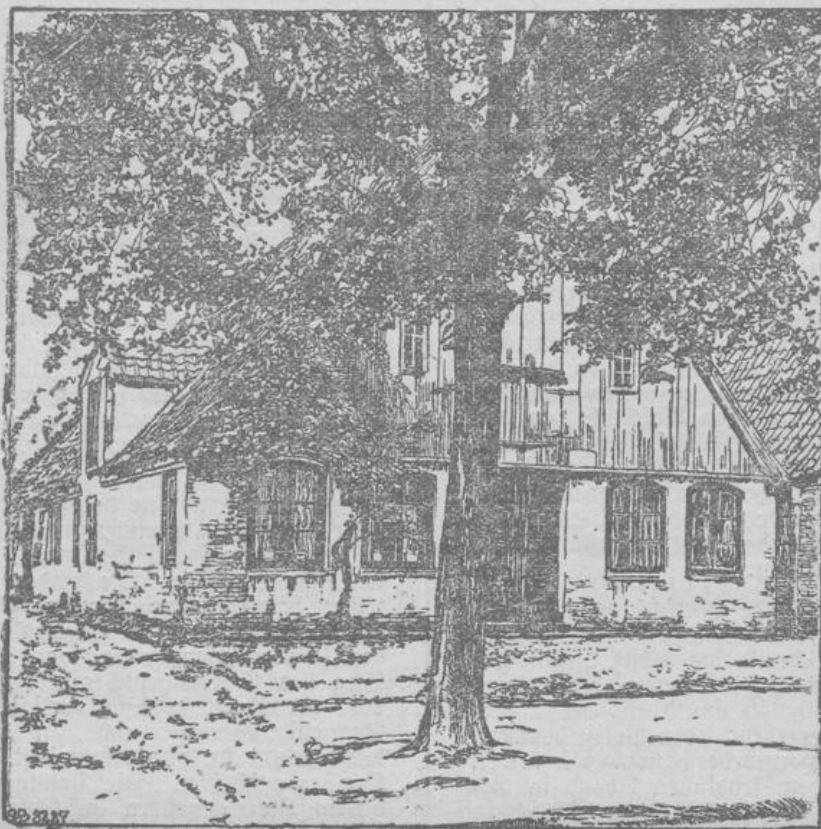
Das dem Abbruch geweihte Geburtshaus Klaus Groths in Heide.
