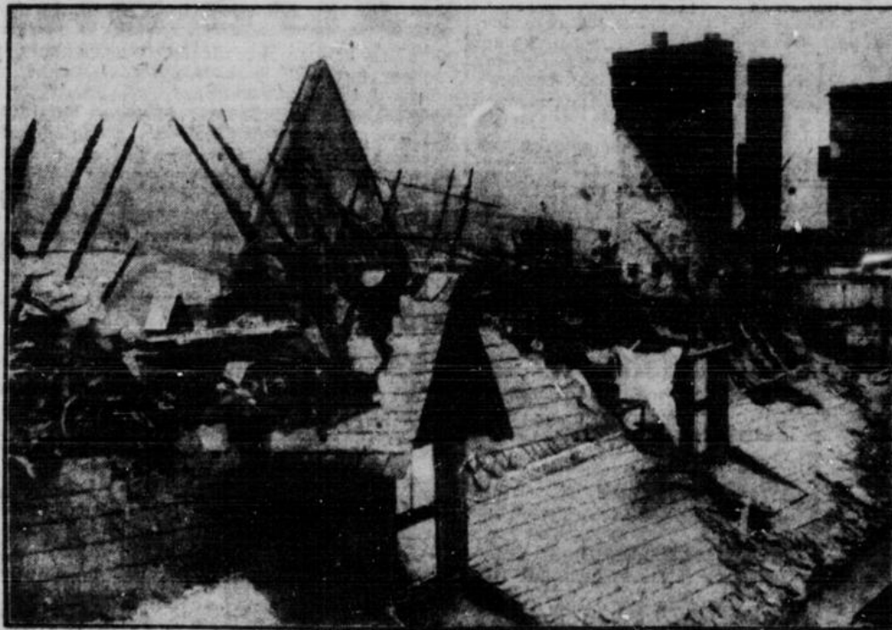
Ein Teil des verbrannten Dachstuhles.
