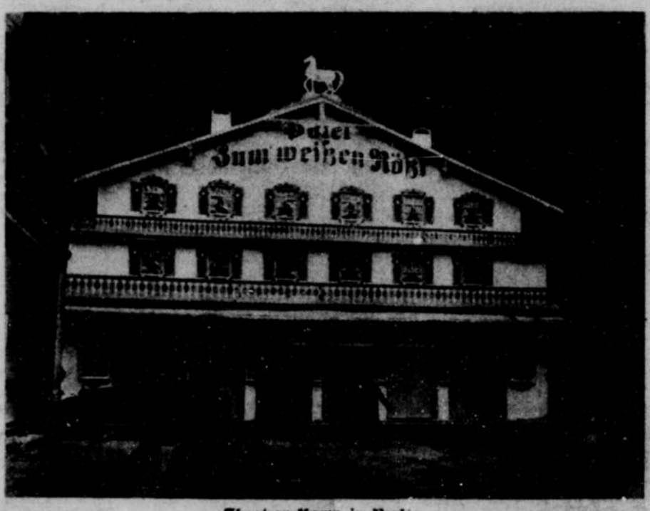
Theaterrefuge in Berlin Anlässlich der Neuinszenierung des „Weißen Röhl“ wurde die Fassade des großen Schauspielhauses in Berlin auf diese Weise „kühnlich“ verkleidet
