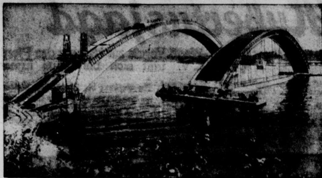
Ueber den Plougastel in der Nähe des französischen Kriegshafens Brest wird eine große Betonbrücke gebaut, deren erster Bogen soeben fertiggestellt wurde. Der Bau geht mit Hilfe von Pontons vor sich. Die Spannweite der Brücke beträgt 850 Meter.
