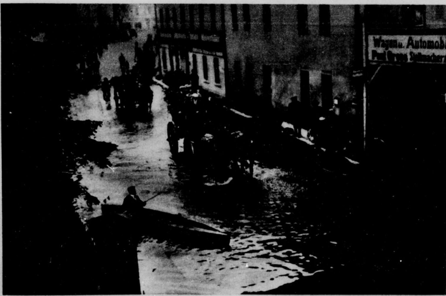
Das Hochwasser in Schleien Das Hochwasser in Guben, Schleien. Durch die Straßen der Stadt konnte man im Fiedelboot fahren Aut. Scherl
