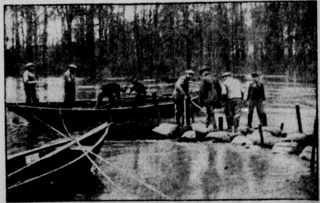
Errichtung eines neuen Schutzdammes mehrere Kilometer von der Oder entfernt.
