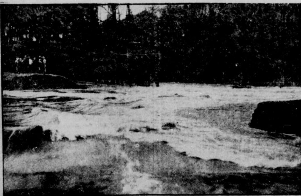
Eine der Bruchstellen des Oderdammes bei Brieg, durch die in einer Breite von 80 Metern die Wassermassen sich ins Land ergießen.
