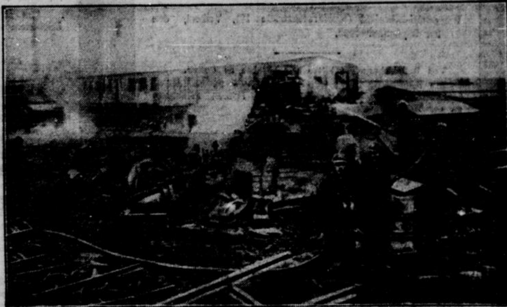
Das abgebrannte Fabrikgebäude.
