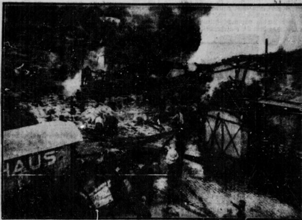
Ein Blick auf die Brandstätte.
