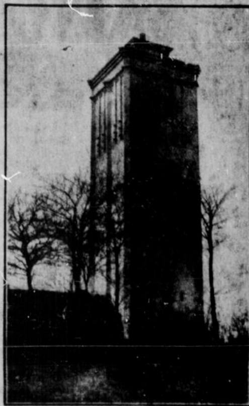
Der neue Wasserturm am Pfaffenhaus. Zur Verbesserung der Wasserversorgung in der Nordstadt Elberfelds.
