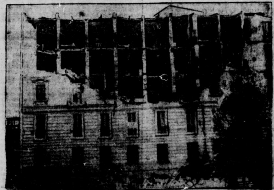
Ein durch das Erdbeben zerstörtes Wohnhaus in der Via Casanova in Neapel.
