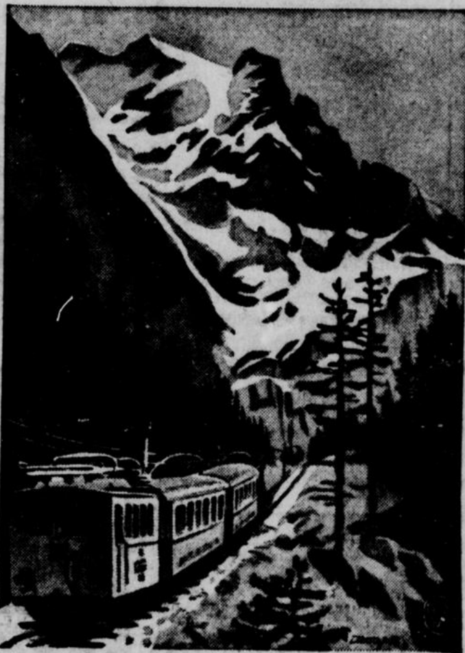
Die bayrische Zugspitzbahn.
