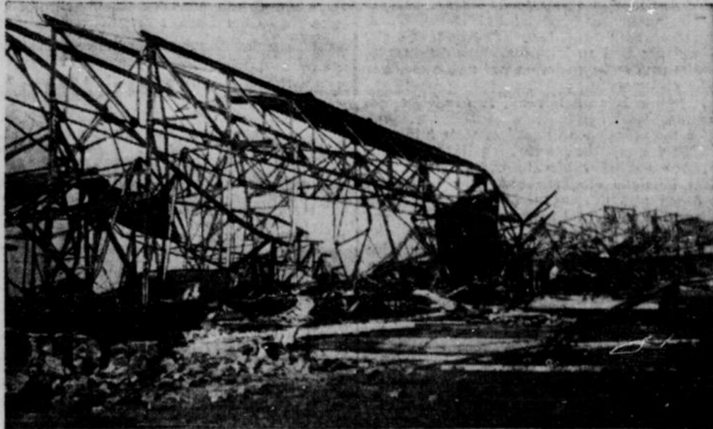
Abbruch der Luftschiffhalle in Griesheim a. M.
