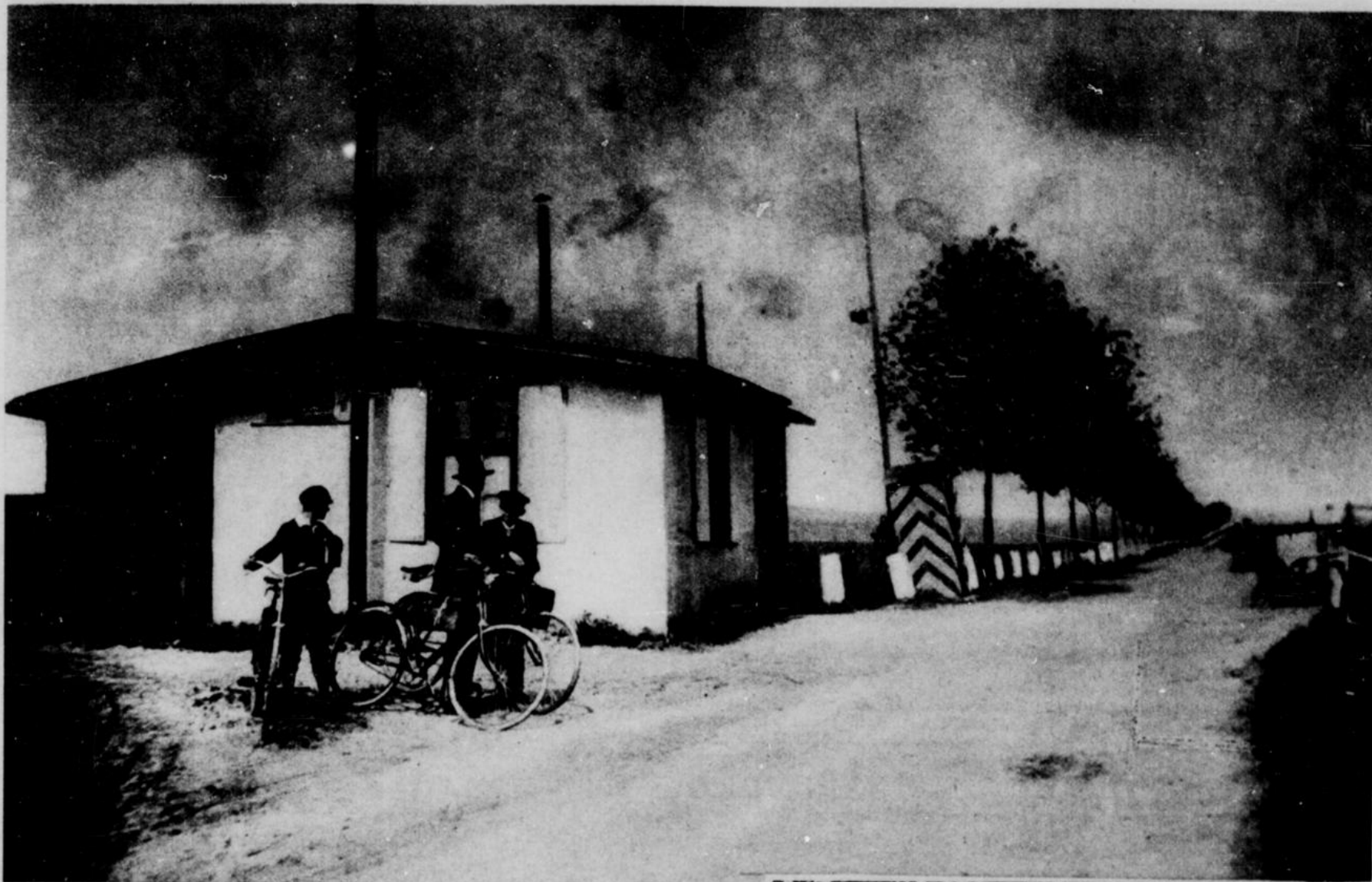
Das deutsche Pafkontrollhaus in Henhöfen, in dem die Verhaftung der Polen erfolgte
