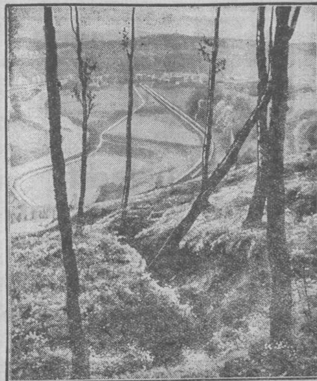
Berggrusich gefährdet eine Eisenbahnlinie.
