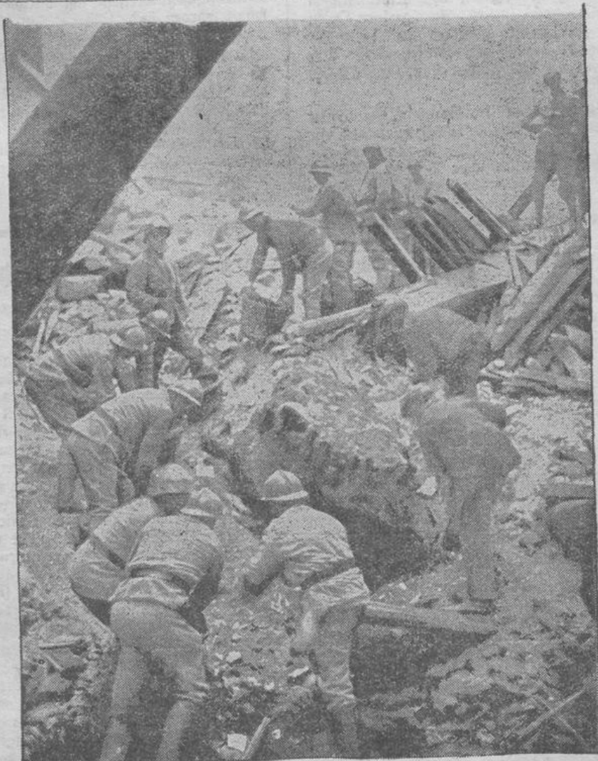
Traurige Arbeit. Die Aufräumarbeiten an der Unglücksstätte in Lyon.
