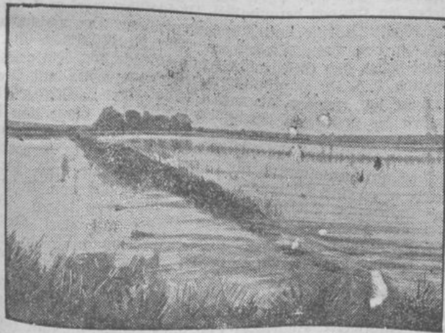
Das Wasser trat über die Dämme
